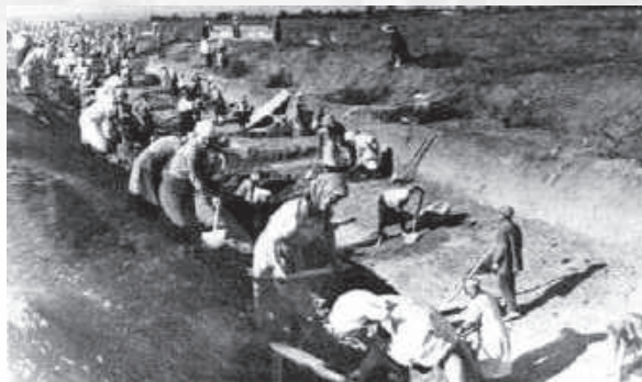
Строительство укреплений «Восточного вала»
