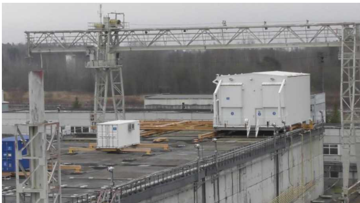
Рисунок 3.2-5. Здание хранилища саморазрушающихся стальных рельсов № 157/1 на АЭС ИНП с группами саморазрушающихся стальных рельсов G1 и G2. Извлекательный блок МО-2.
