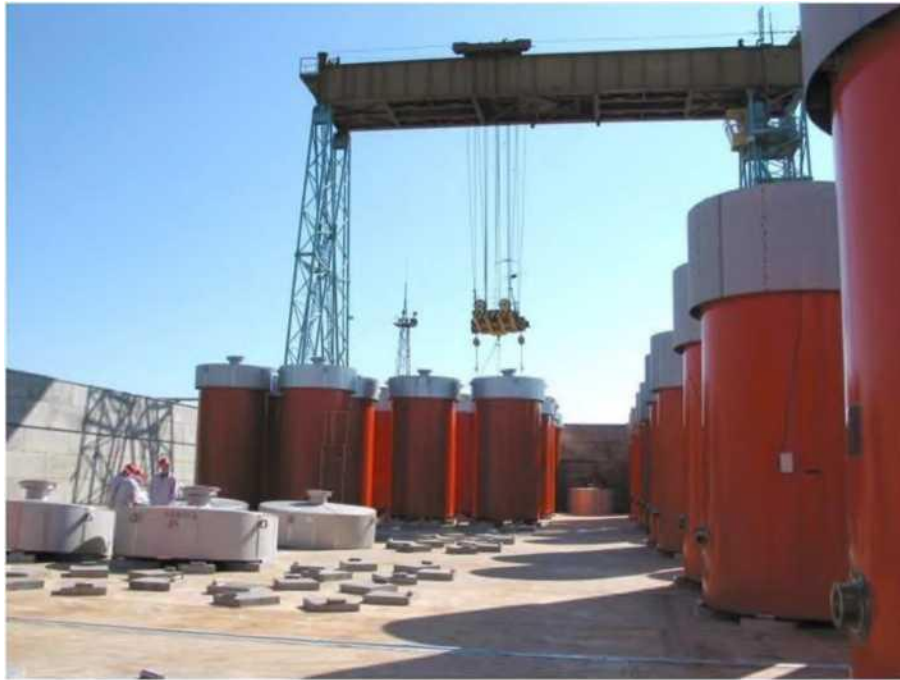
Рисунок 3.2-1. Хранилище отработанного ядерного топлива ISFSF-1 с контейнерами.
