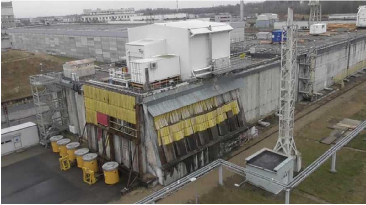
Рисунок 3.2-7. Сооружение хранилища ТРО на ИАЭС с группой G3 с блоком МО-3.
