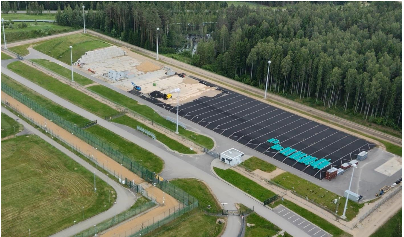
Рисунок 3-4. Модуль хранилища ОНУРО с инженерными барьерами и защитной стеной, сформированной после погрузки конкретной компанией
